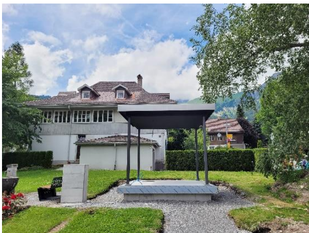
Bild: Baustelle CUBE Lenk im Juli 2024
